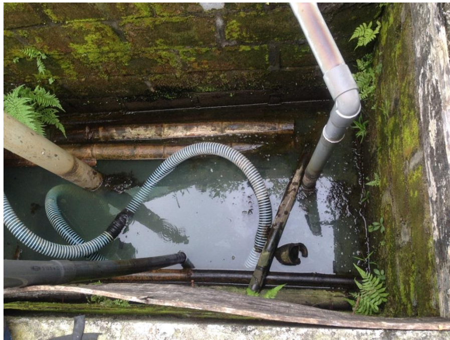
Gambar 4. 2 Kondisi Sumber Air Baku Sebelum Pengurasan
