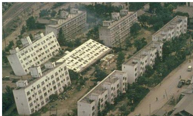
Gambar 3.1 Likuifaksi yang memicu kerusakan apartemen Kawagishi-cho yang disebabkan oleh gempa Nigata 1964 ( Kramer, 1996)
