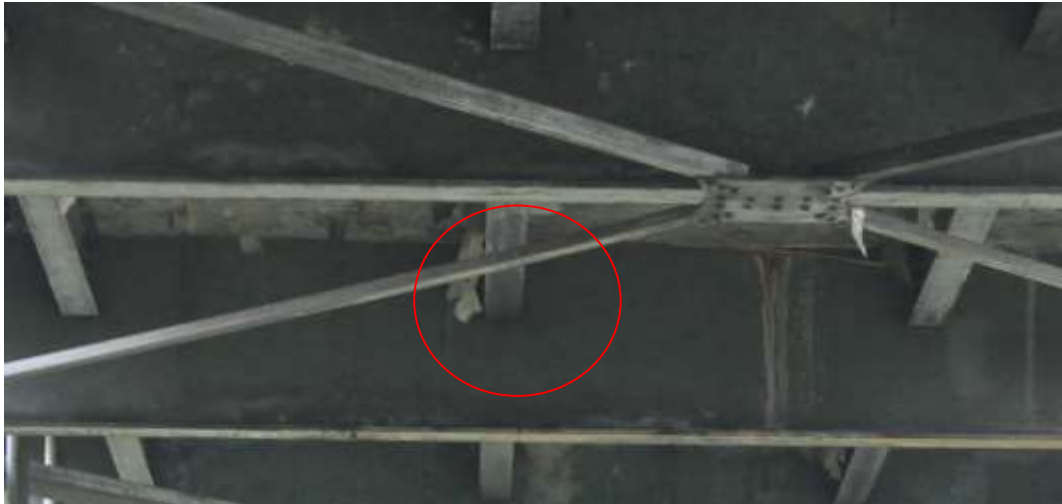
Gambar 5.36 Sambungan Gelagar Interior Jembatan Kondisi Eksisting
