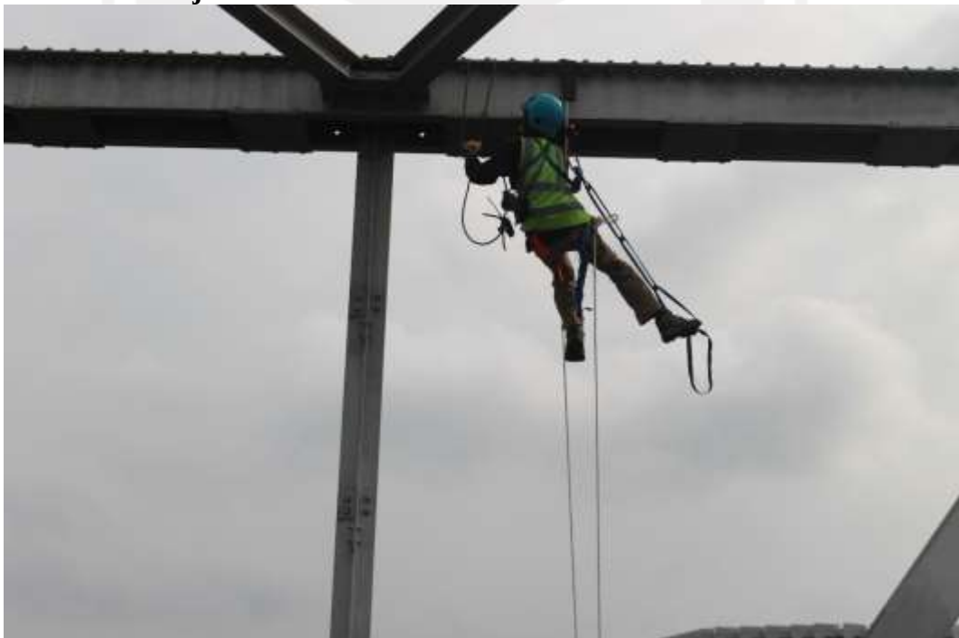
Lampiran A.7 Pengukuran Penampang Elemen Bagian Atas Struktur Atas Jembatan Sardjito 1
