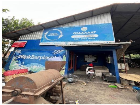
Bangunan TPS 3R GIAAAAAT
