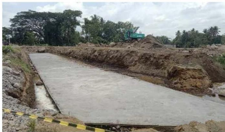
Gambar 3. 7 Pengecoran Lantai Kerja
