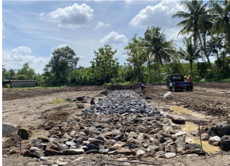
Gambar 3. 5 Proses Pemasangan Batu
