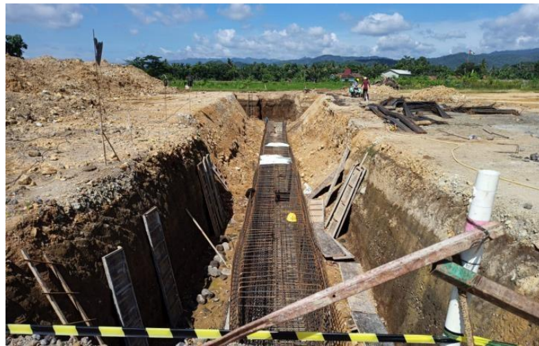
Gambar 3. 8 Proses Pekerjaan Pembesian
