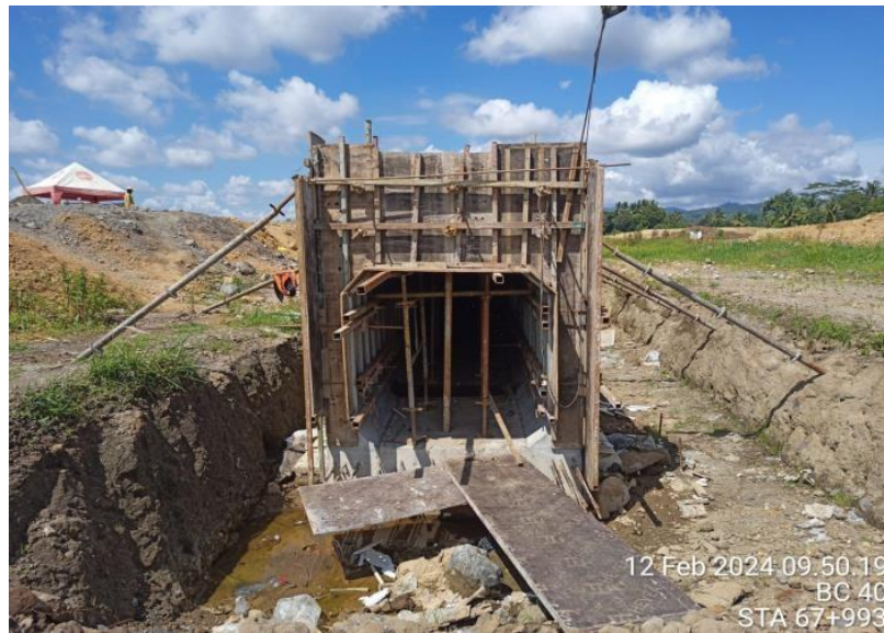
Gambar 3. 9 Proses Pemasangan Bekisting
