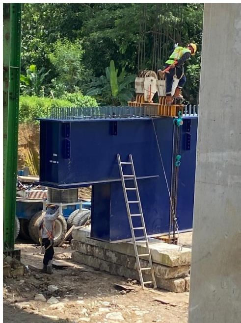
Gambar L-9.4 Proses pemasangan Lifting Gear
