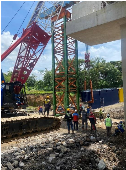
Gambar L-9.3 Proses peletakan Girder ke lokasi kerja
