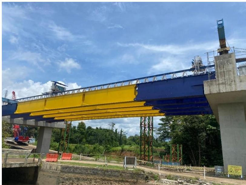
Gambar L-9.6 Girder terpasang
