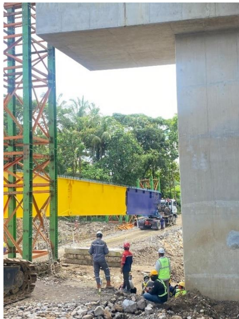
Gambar L-9.2 Proses Mobilisasi Girder
