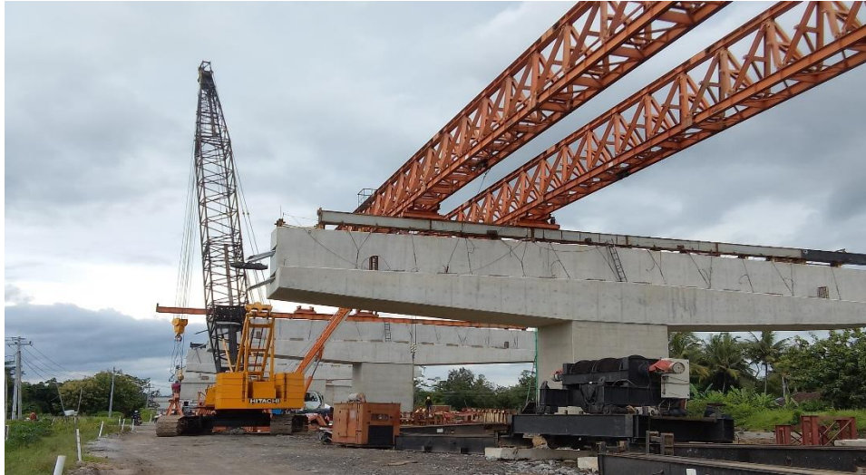
Gambar 3. 6 Erection Girder Menggunakan Launcher
