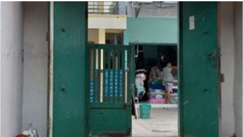
Gambar. 105 Pintu Gerbang 12 Januari 2020
