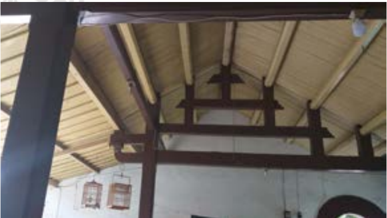
Gambar 107 Struktur atap rumah 12 Januari 2020
