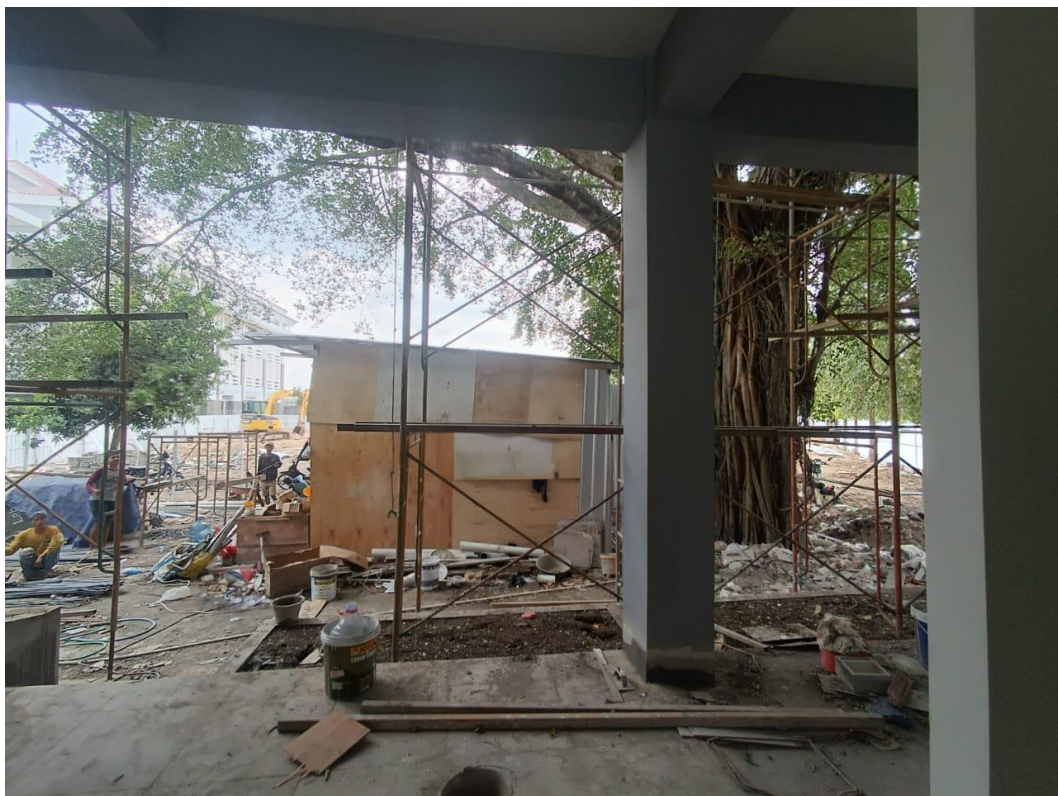
Gambar 4.2 Kondisi Proyek (Sumber: Dokumentasi Pribadi)
