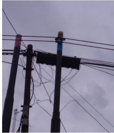
Gambar 3.7. ODP tiang/ pole
