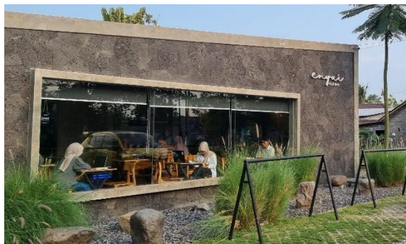
Gambar 2 Jendela besar pada tampak barat Kafe Sumber : Penulis, 2024
