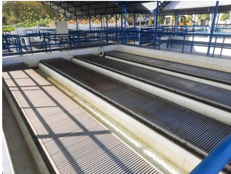
Gambar 4. 15 Unit Filtrasi
