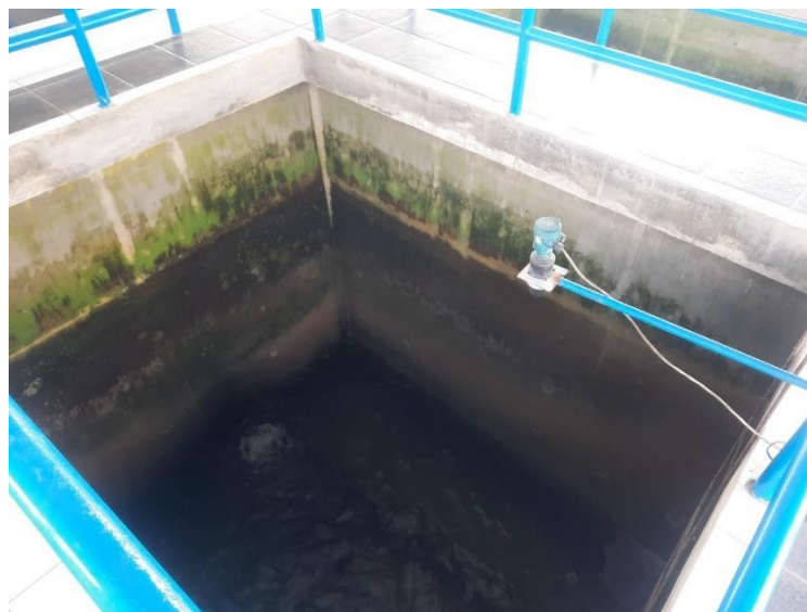
Gambar 4. 14 Bak Sedimentasi
