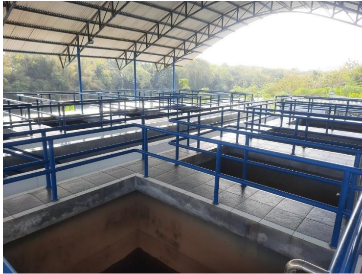
Gambar 4. 13 Unit Sedimentasi
