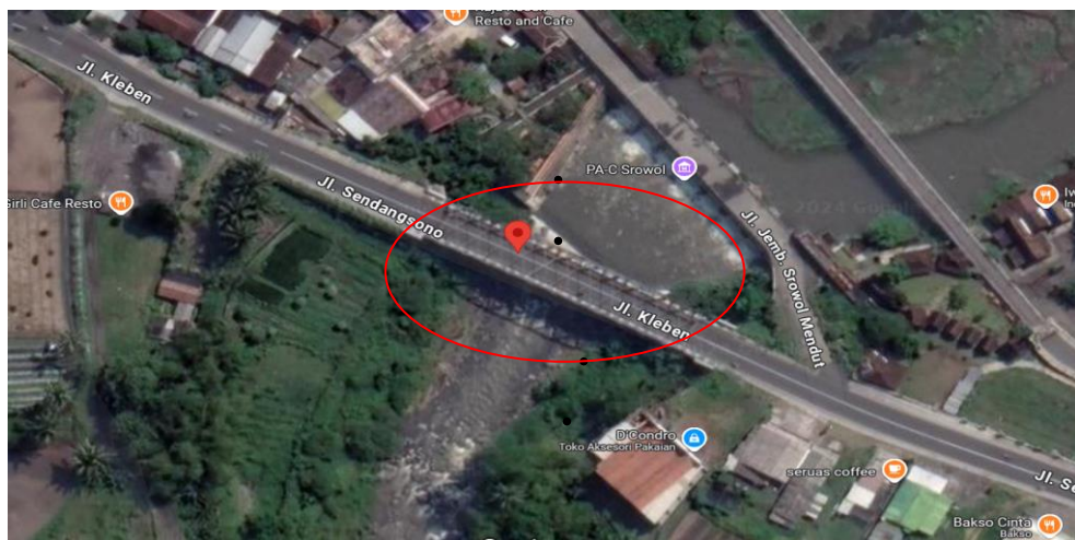
Gambar 4. 1 Lokasi Jembatan Pabelan (Google Maps)
