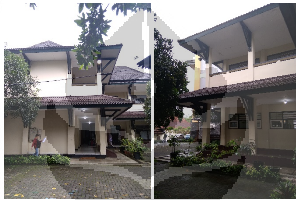
Gambar 1. 3 Kondisi Fasad Eksisting Bangunan
