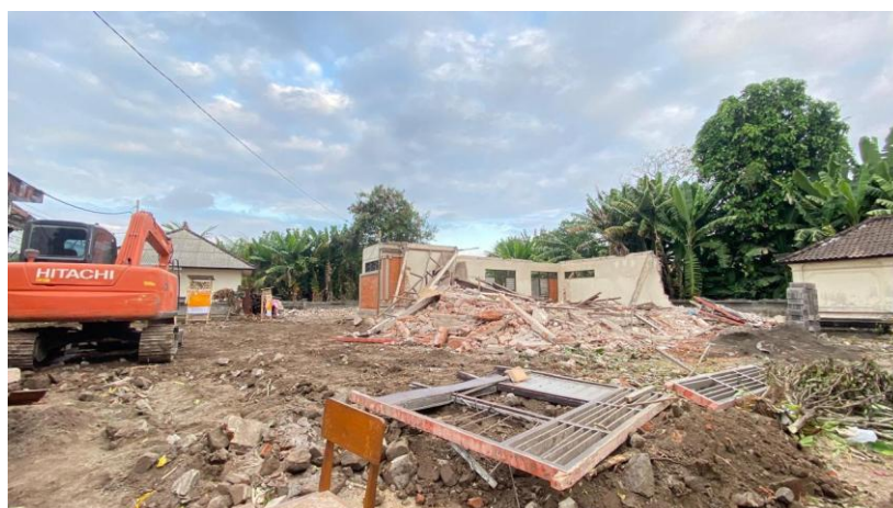
Gambar 4. 2 Kondisi Awal Proyek
