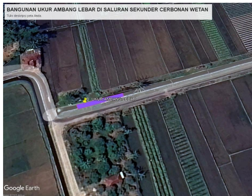
Gambar 4. 1 Lokasi Bangunan Ukur Ambang Lebar
