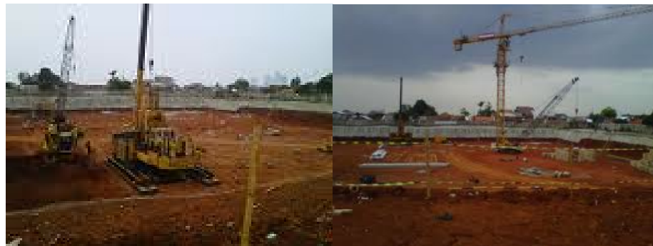
Gambar 2.10. Pemasangan Tiang Pancang
