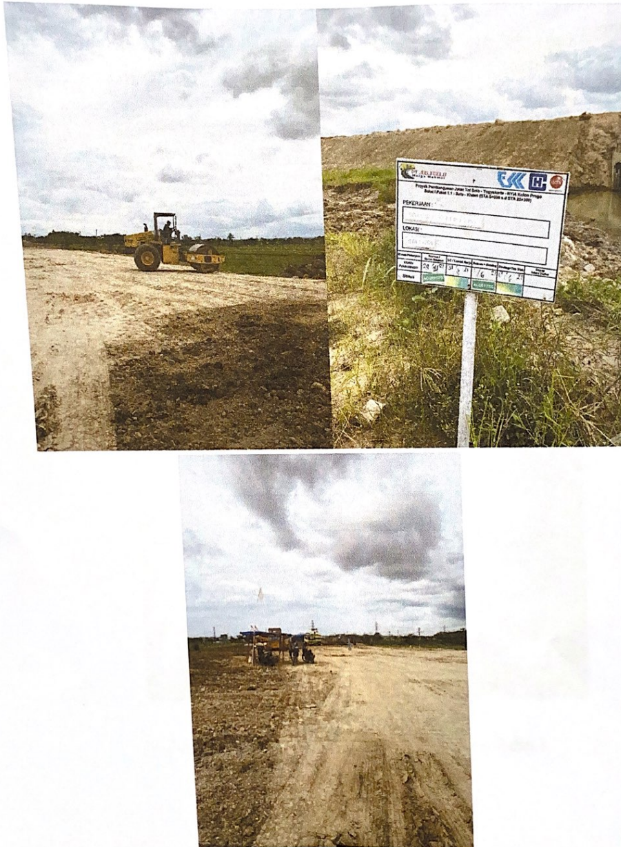
Situasi pekerjaan memasuki stasiun 2.
