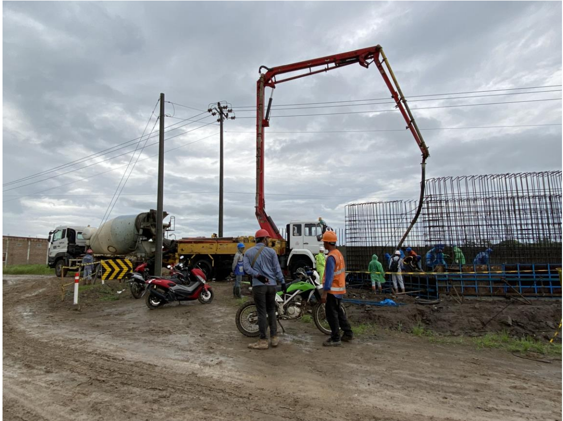
Gambar L-1.1 Pekerjaan Pengecoran
