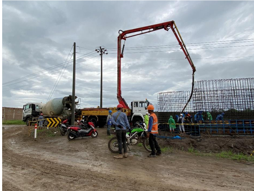
Gambar 5.4 Pekerjaan pengecoran yang tetap berlangsung saat hujan
