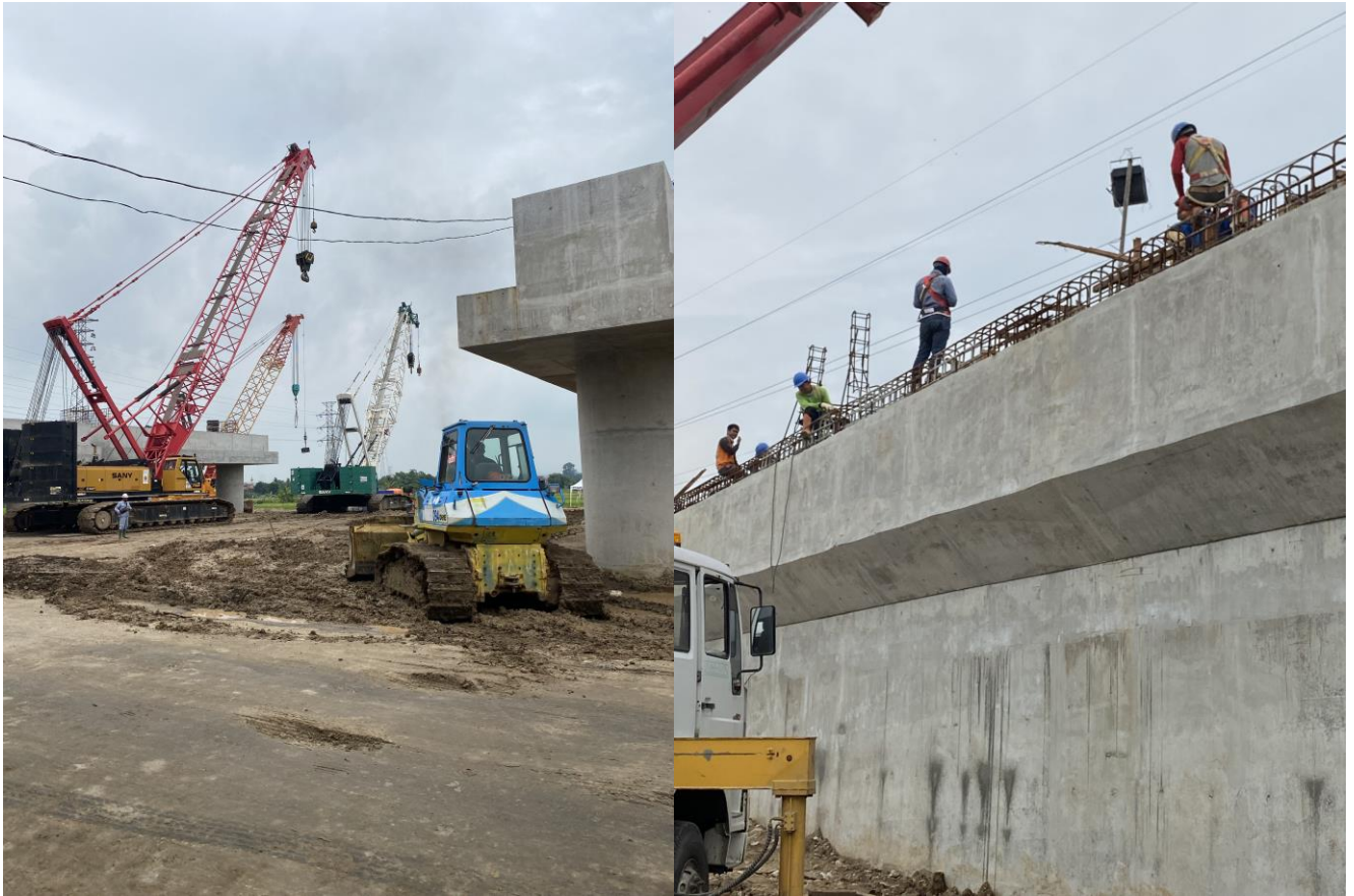
Gambar L-1.3 Pekerjaan Penyiapan Lahan dan Struktur Atas
