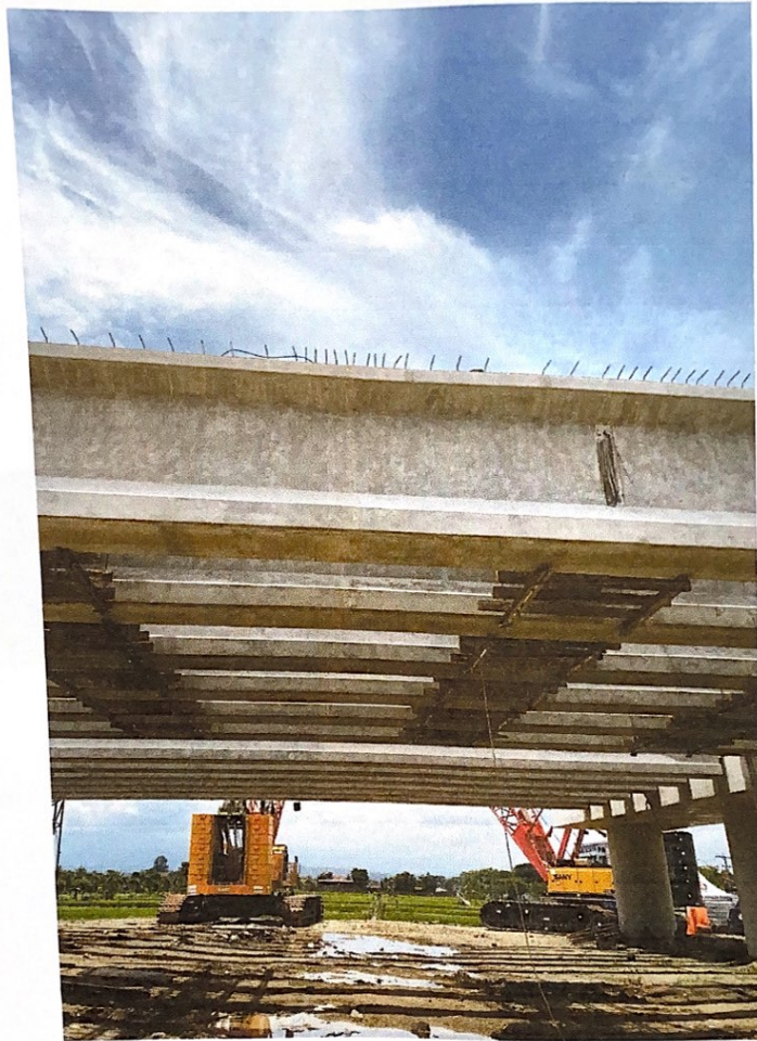
Balok girder yang sudah dapat terpasang dengan baik.
