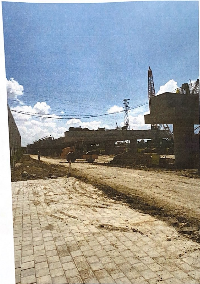
Pekerjaan penyiapan lahan tanah di antara tiang 2 dan 3.
