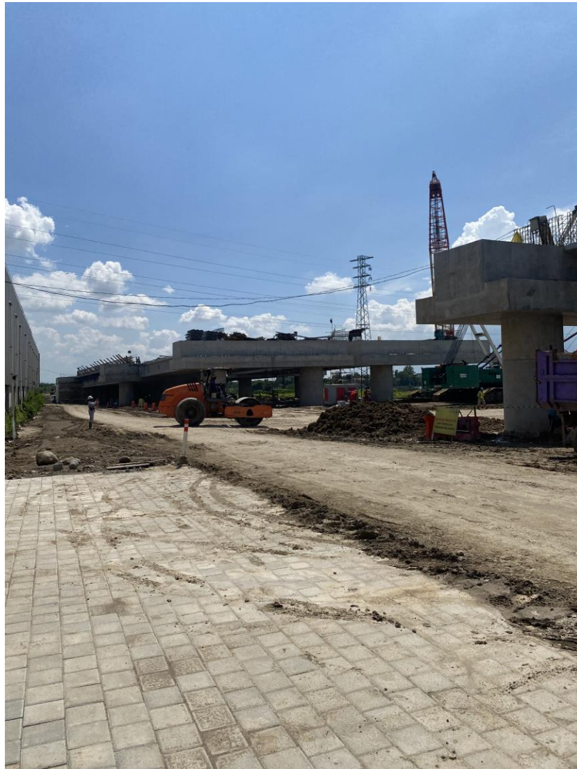
Gambar L-1.6 Situasi Pekerjaan di Stasiun 1
