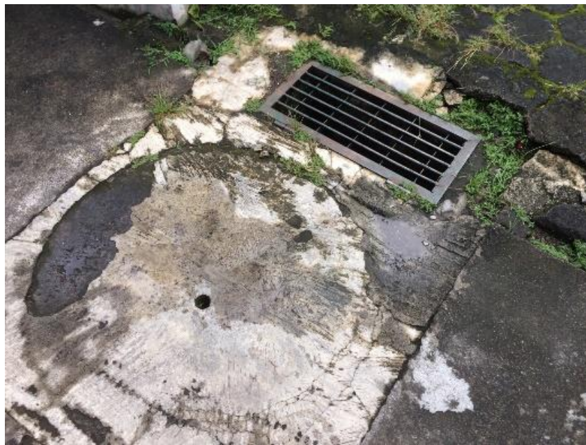
Gambar 4.7 Sumur Resapan di Kawasan Gendeng, Bacirow, Yogyakarta
