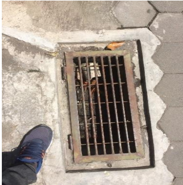
Gambar 4.10 Bak Kontrol dan Sumur Resapan di Kawasan Warungboto, Umbulharjo, Yogyakarta
