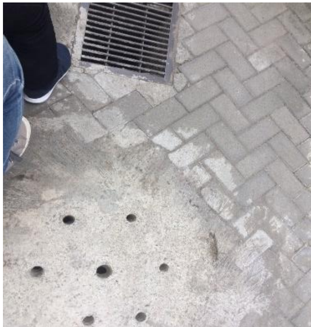
Gambar 4.10 Bak Kontrol dan Sumur Resapan di Kawasan Warungboto, Umbulharjo, Yogyakarta
