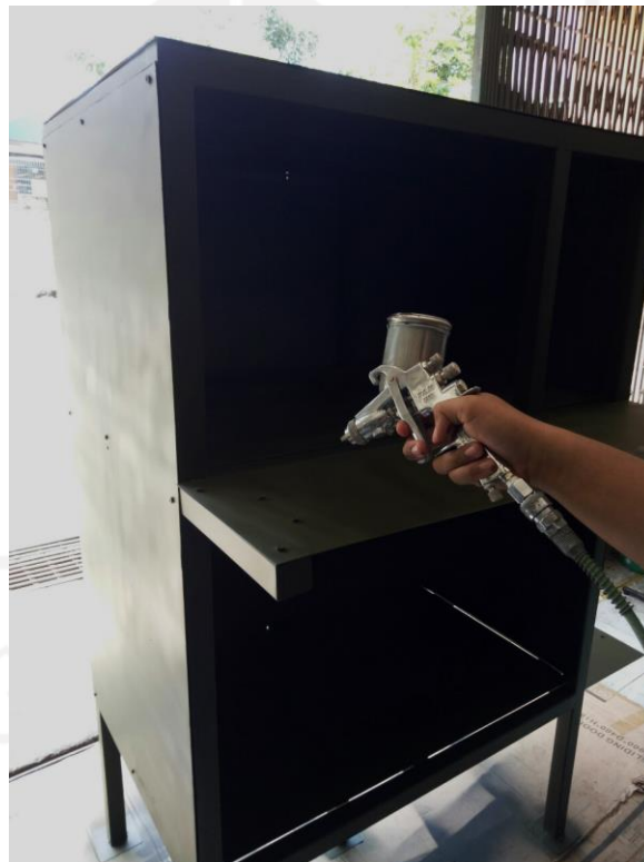
Gambar 4- 17 Pengecatan dasar rangka mesin vulkanisasi.
