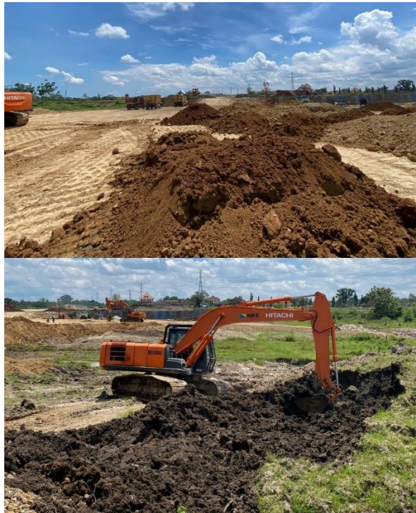
Gambar 5. 4 Pekerjaan Galian Timbunan
