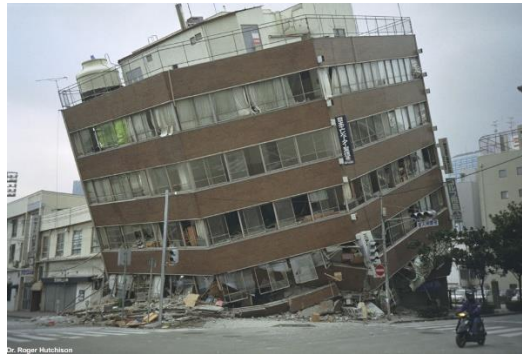
Gambar 2.2. Keruntuhan Geser Pada Bangunan
