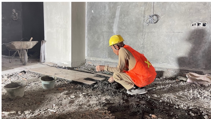
Gambar 5.2. Proses Pemasangan Granit Lantai pada Tukang 2
