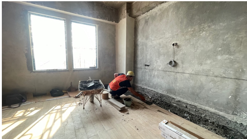
Gambar 5.1. Proses Pemasangan Granit Lantai pada Tukang 1
