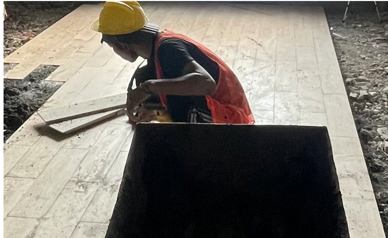
Gambar 5.3. Proses Pemasangan Granit Lantai pada Tukang 3
