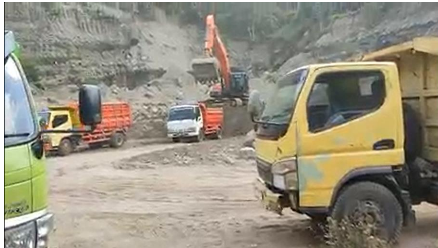
Lampiran 46 Gali Muat Angkut Oleh Excavator dan Dump Truck
