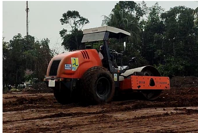
Gambar 5. 15 Vibrator Roller Hamm 311d (Sumber: Pengamatan Lapangan, 2024)
