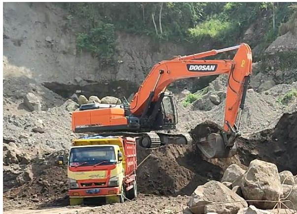
Gambar 5. 11 Excavator Doosan Dx 300ca (Sumber: Pengamatan Lapangan, 2024)
