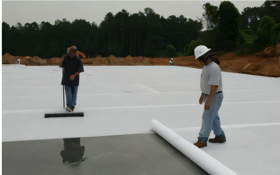
Gambar 3.2 Metode perawatan penutupan beton menggunakan plastik (Sumber : Internet)
