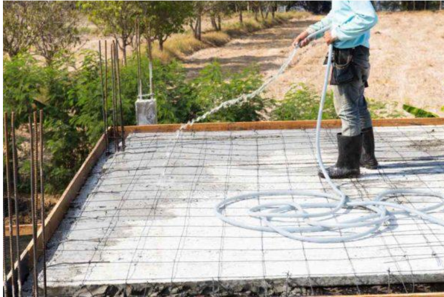
Gambar 3.1 Metode perawatan penyiraman beton (Sumber: Internet)
