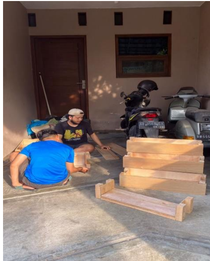
Gambar L- 10.1 Pembuatan Bekisting
