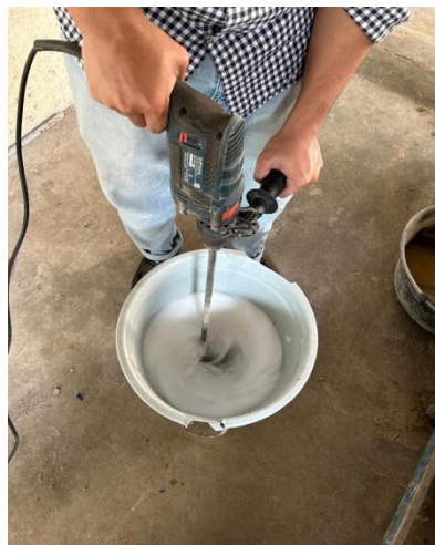
Gambar 4. 17 Pembuatan Foaming Agent
