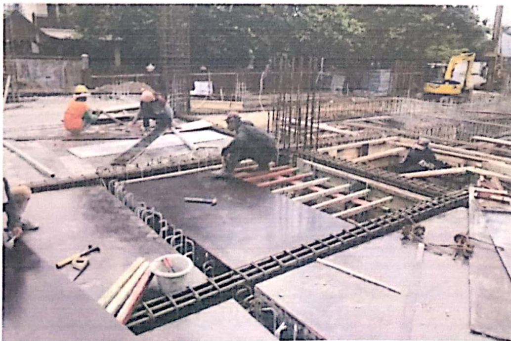
Gambar 5.5. Dokumentasi Proses Pekerjaan (Sumber: Dokumentasi Proyek MPP)
