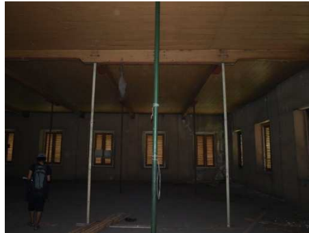
Struktur Kolom Besi Gedung Joeang didalam Ruangan
