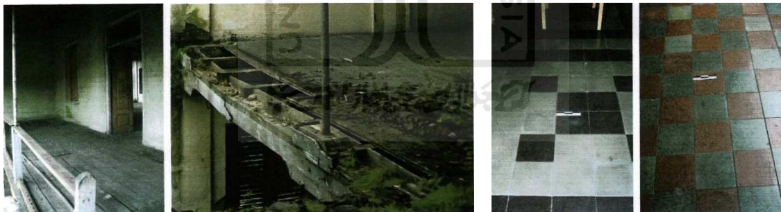
(Lantai berupa papan kayu jati pada lantai 2 dan detail struktur lantai 2)
