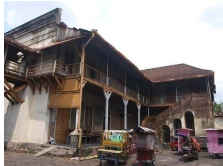
Struktur Kolom Kayu dan Besi Gedung Joeang
