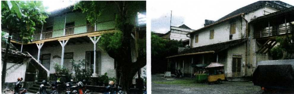
Gedung Sayap Barat (Kiri) dan Gedung Tengah (Kanan) Tampak Belakang
