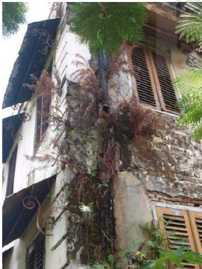
Struktur Pilaster Bekas Gedung Joeang
