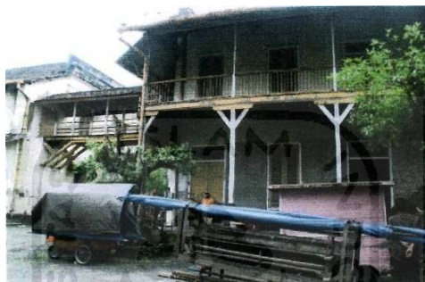
Gedung Sayap Timur Tampak Belakang
