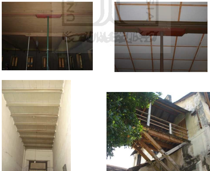
Gambar 3.3.4 : Struktur Balok Bekas Gedung Joeang
