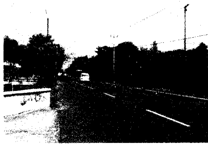
Jaringan listrik dan telepon
