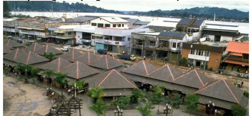
Gambar 3.16 Atap Bangunan Citra Niaga.
