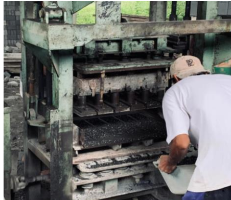
Gambar L-2. 3 Proses Pencetakan Paving Block
