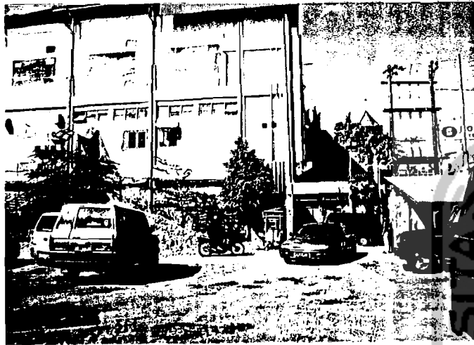
• VIEW DR. ARAH BARAT KE TIMUR (LAKS) (MENGHADAP KE ARAH BANGUNAN TOKO TEKSI)
